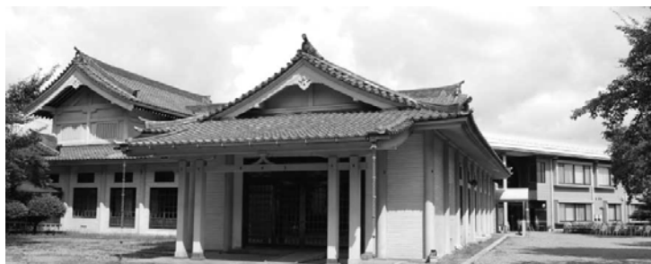
教務支庁神殿屋根の瓦葺き替え直前
