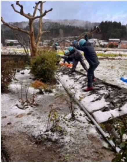
雪の残る中ブロック解体を行う隊員
