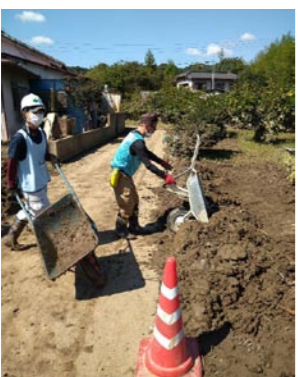
磐田市豊岡地区で作業の様子
